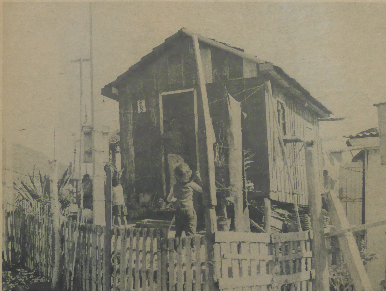
Vila ZH é formada por casas sem as mínimas condições de higiene e construídas pelos próprios moradores
