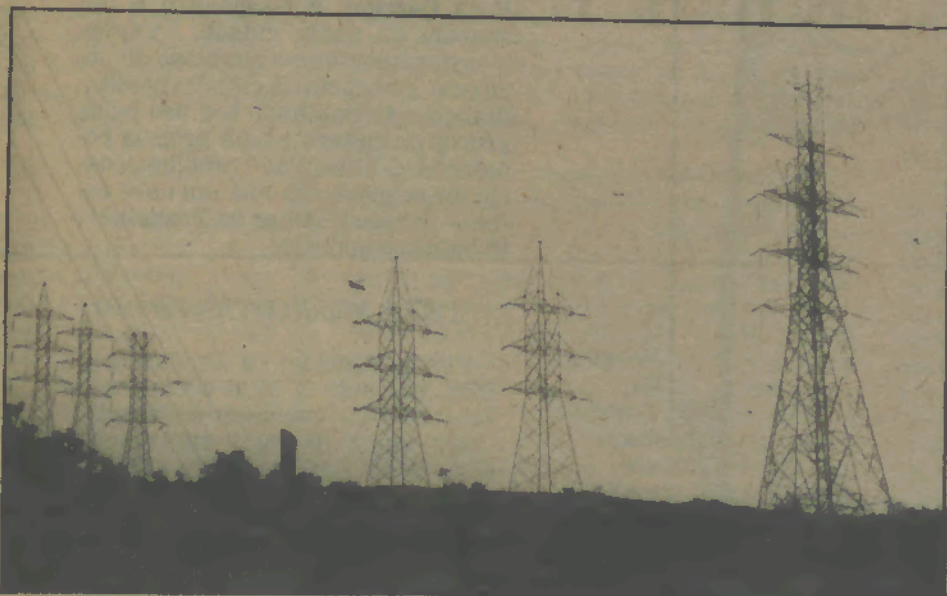
Linhas de transmissão exigem manutenção constante
