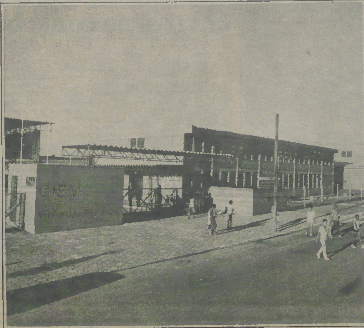
CIEM instalado no Centro Comunitário da Vila Restinga.
